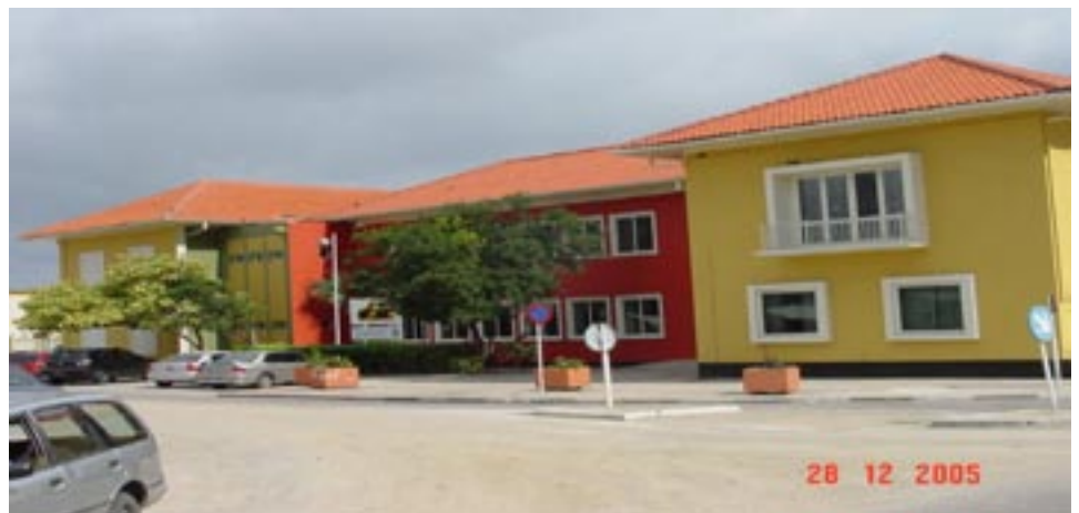
Aruba, 22 december 2005 De minister van Sociale Zaken en Infrastructuur
